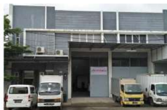
Warehouse Cengkareng Jakarta Barat
